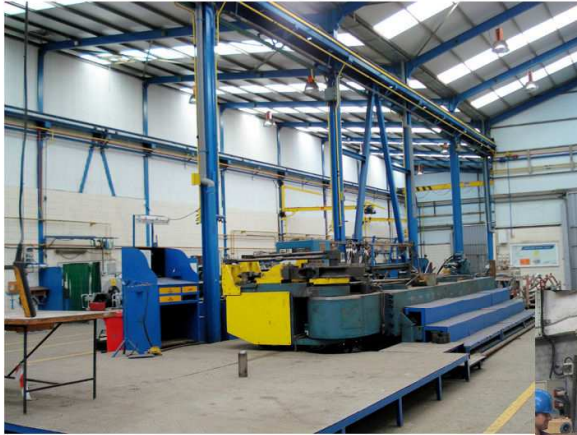
Curvadora de tubos
